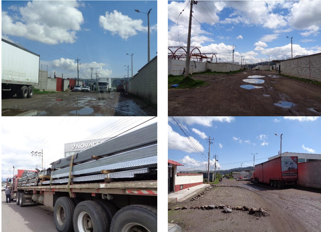
Figura 4-39 Imágenes sobre el estado de la vía pública dentro del PIT
