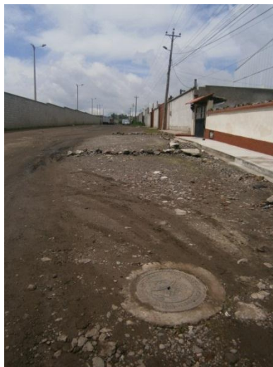
Figura 4-8 Presencia de alcantarillado público (Calle Novena)
